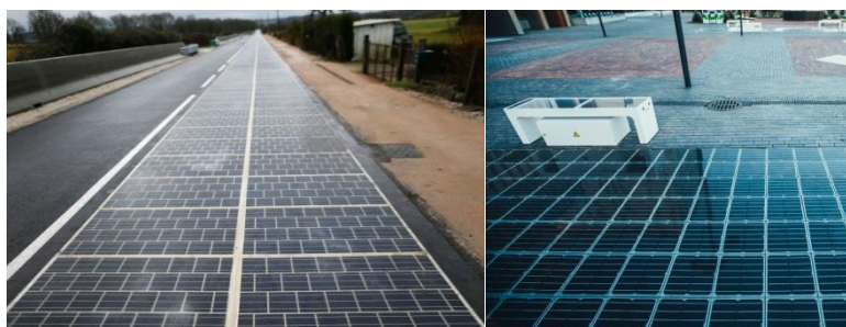
Abb. 43 In Pilotprojekten wird die Integration von Photovoltaik in öffentliche Plätze (rechts [30]), Straßen (links [31]) und Fahrradwege erprobt.
