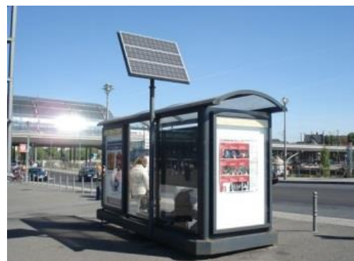
Abb. 37 Solarstromversorgte Bushaltestelle in Berlin. Die dadurch ermöglichte Beleuchtung lässt den Busfahrer wartende Personen nachts besser erkennen. [24]
